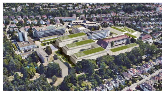
Neubauprojekt Klinikum Esslingen
